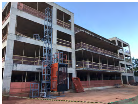
20 – Instalação do elevador cremalheira
