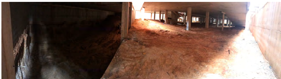
9 – Escavação do reservatório e aterro do 2º subsolo
