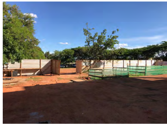
8 – Canteiro (central de armadura) e cerca
