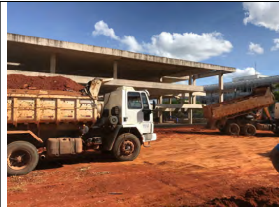
21 – Execução do aterro frontal
