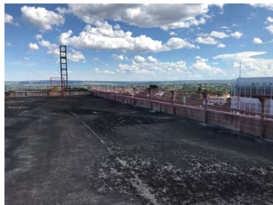
18 – Guarda corpo cobertura / cremalheira
