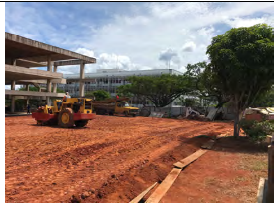
22 – Compactação aterro frontal (canteiro)
